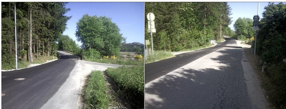
Figur 6.1. Dagens situasjon, Gamle Eigerøyveien sett mot krysset (til venstre) og innover (høyre).
