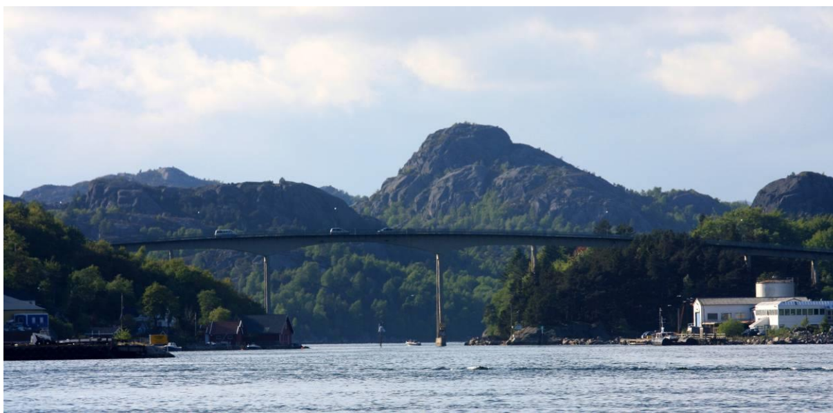
Figur 7.3. Eigerøy bru (© Wikipedia Commons). Langholmen med eksisterende bebyggelse til høyre i bildet. I bakgrunnen vises tydelig det typiske, regionale anortositlandskapet, med veksling mellom skog og bart fjell med knudrete småformer.
